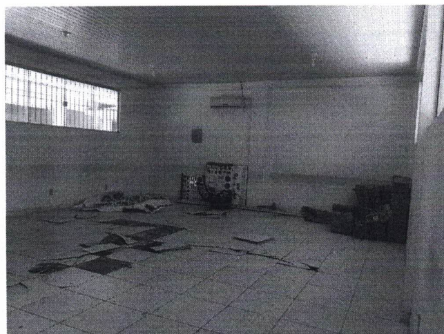
Fotos 3 e 4: Sala de informática-desplacamento de revestimento do piso
