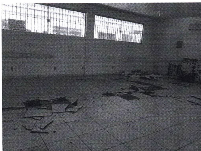
Fotos 3 e 4: Sala de informática-desplacamento de revestimento do piso
